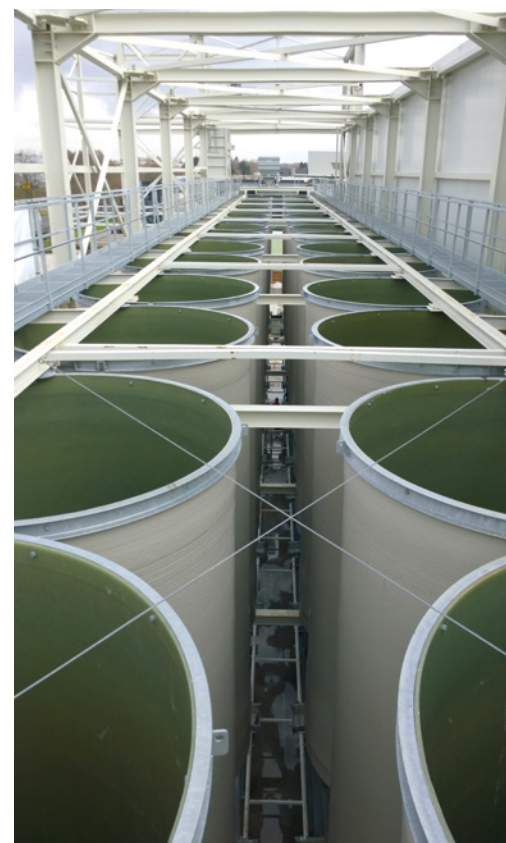
Zuschlagstoffsilos von oben
